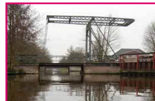
Trambrug, Nieuw Amsterdam
